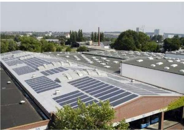
**Abbildung 4: Haus in Kassel; PV-Anlage 9 kWp**
