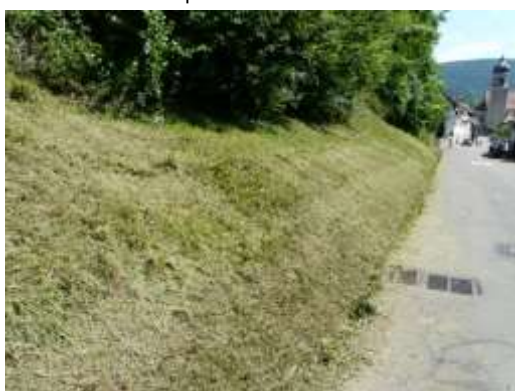
Abbildung 25: Böschung nördlich der Kirchstraße. Aufgrund intensiver Pflege zur Aktivitätsperiode von Reptilien ist eine Habitateignung vermutlich nicht mehr gegeben.
